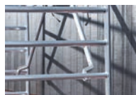
Gepresste Verbindungen zwischen Klaue und Strebenrohr
