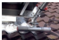
Kunststoffschutz schützt das Dach vor Beschädigungen.
