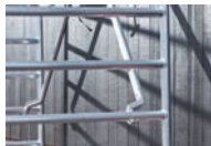
Gepresste Verbindungen zwischen Klaue und Strebenrohr
