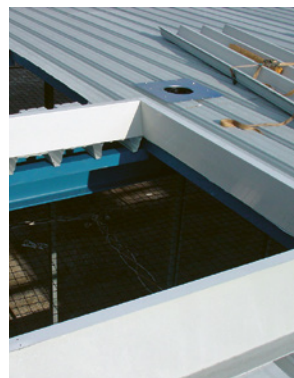
2 Auffangnetz unmittelbar unter Dachöffnungen
