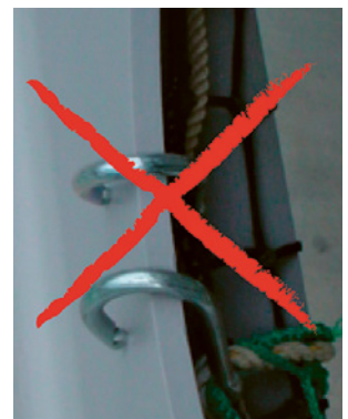
3 Offene Karabinerhaken verlieren massiv an Tragfähigkeit. Grundsätzlich keine Karabinerhaken für die Netzmontage verwenden!
