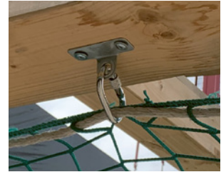
5 Aufhängung mit geprüftem Befestigungspunkt und Karabiner.
