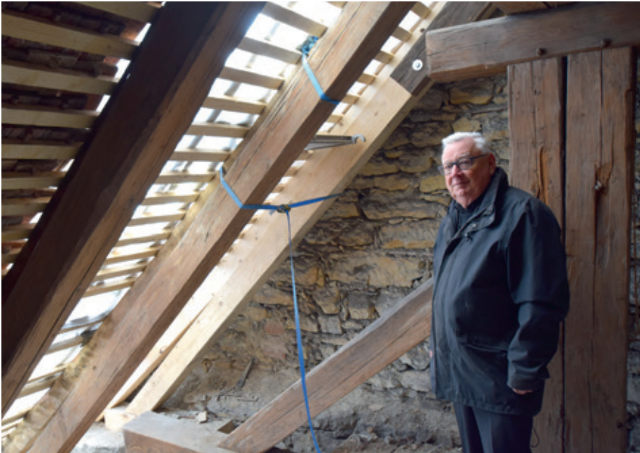
Peter Schibli zeigt die alten und neuen Dachbalken.
