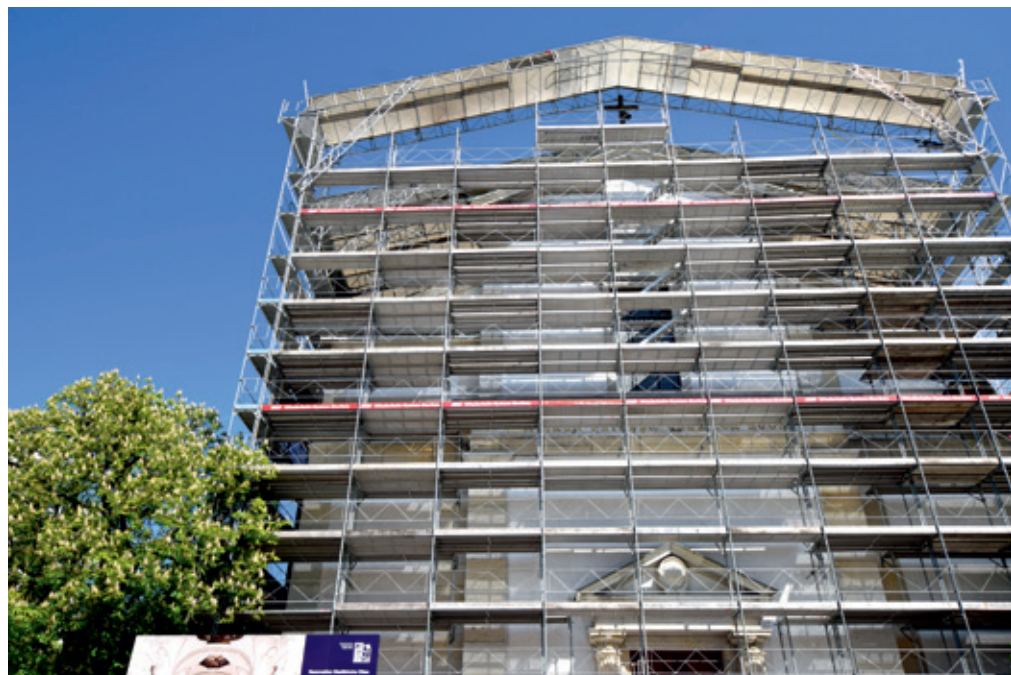
4'000 m 2 Fassadengerüst und 1'500 m 2 Dachgerüst kleiden die Kirch St. Martin ein.
